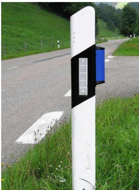
Namestitev modre odsevnika na obcestni smernik
