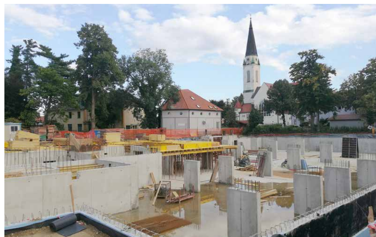
Gradbeno podjetje Drava gradi nov poslovni objekt, ki bo namenjen pisarnam.
