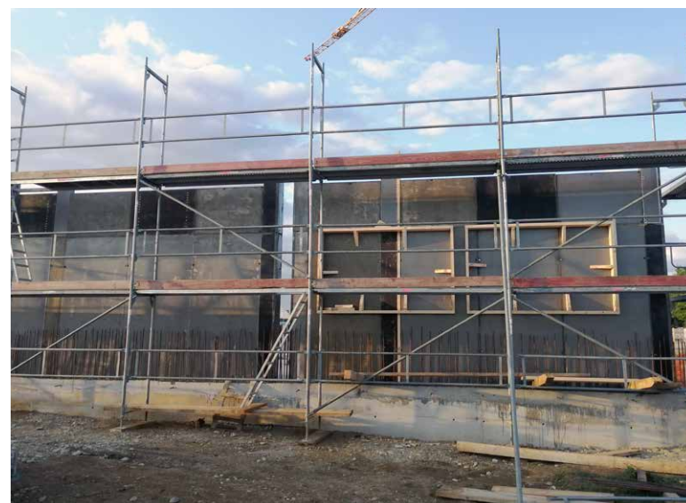
Zaradi prostorskih težav v centru Murske Sobote bo Pošta Slovenije celotno dostavo preselila na Bakovsko ulico.
