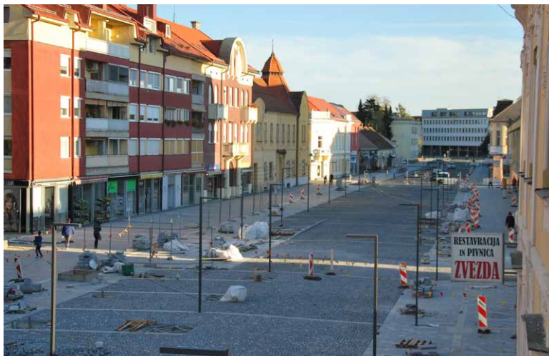
V zaključni fazi so elektroinstalacijska dela po celotnem območju ureditve.
