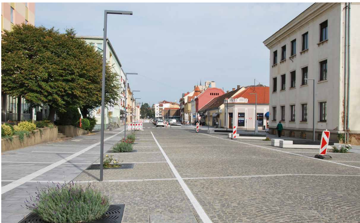
Vsa pogodbeno dorečena dela potekajo po zastavljenem načrtu in bodo, kot zagotavlja Hauko, končana v dogovorjenem roku, ki je 6. december 2020.
