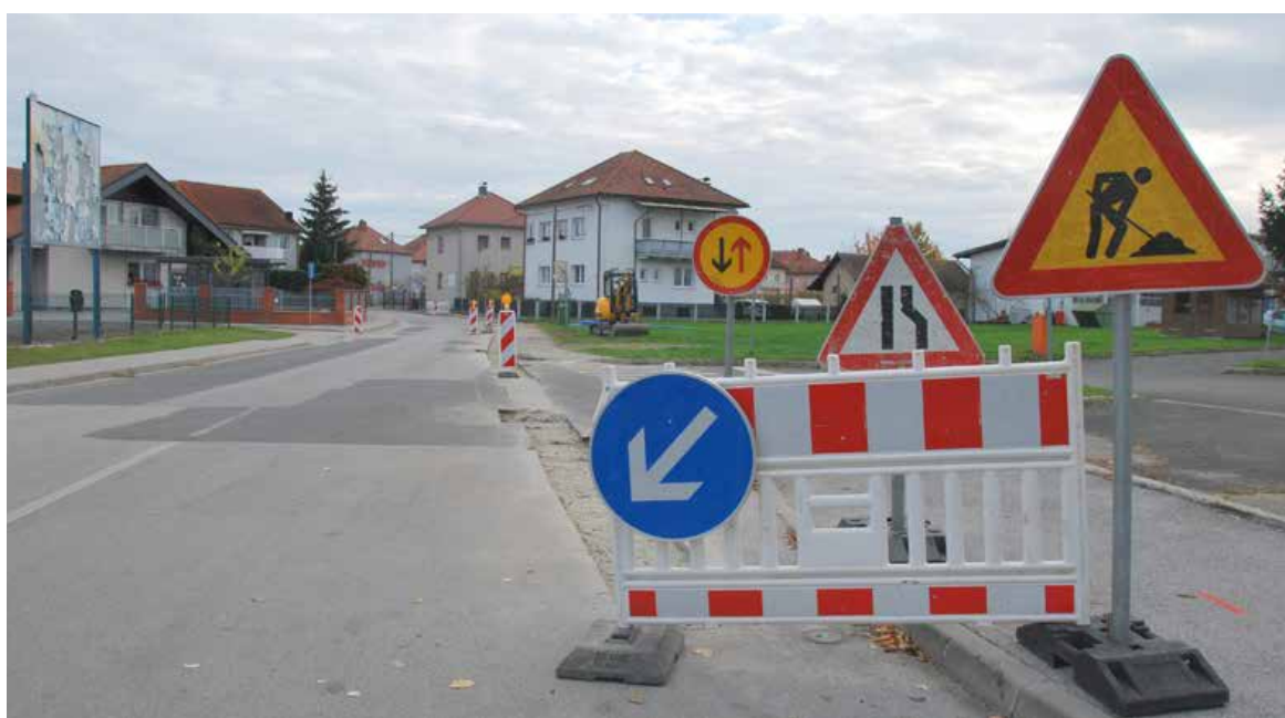
V Ulici Štefana Kuharja obnavljajo vodovodno omrežje, dela so že v zaključni fazi.
