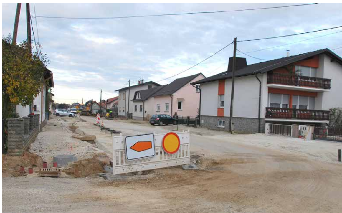
Gradbeni stroji brnijo tudi na Kroški ulici, kjer potekajo dela projekta celovite obnove in vzpostavitve kakovostnih kolesarskih povezav.
