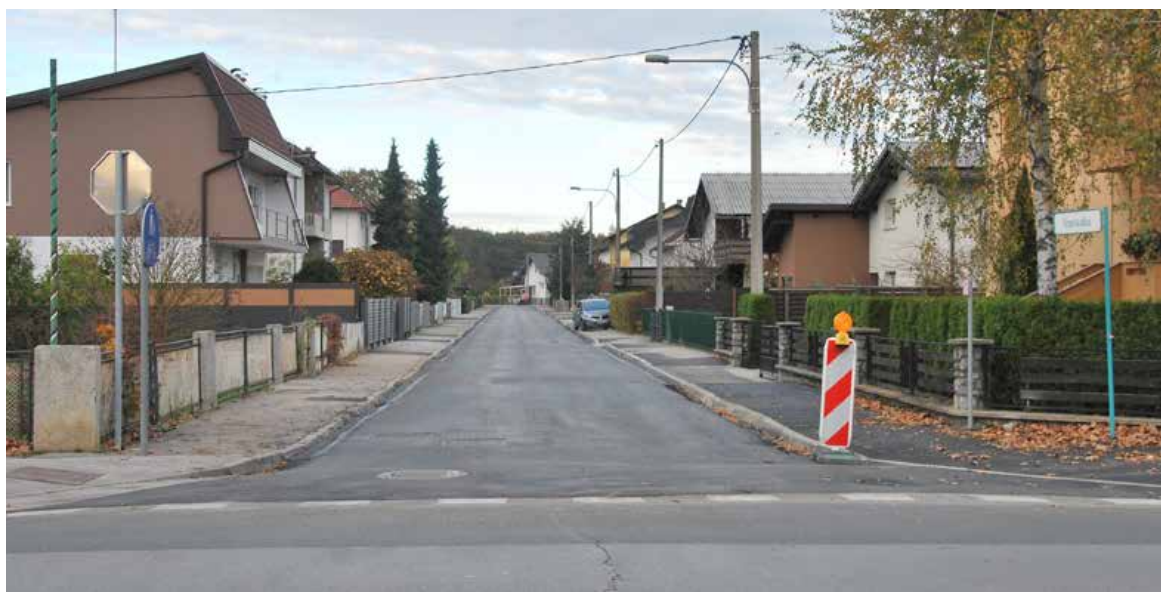
Novo asfaltno prevleko so že dobili Vrazova ulica (na fotografiji) in Aškerčeva ulica ter dva kraka Južne ulice.
