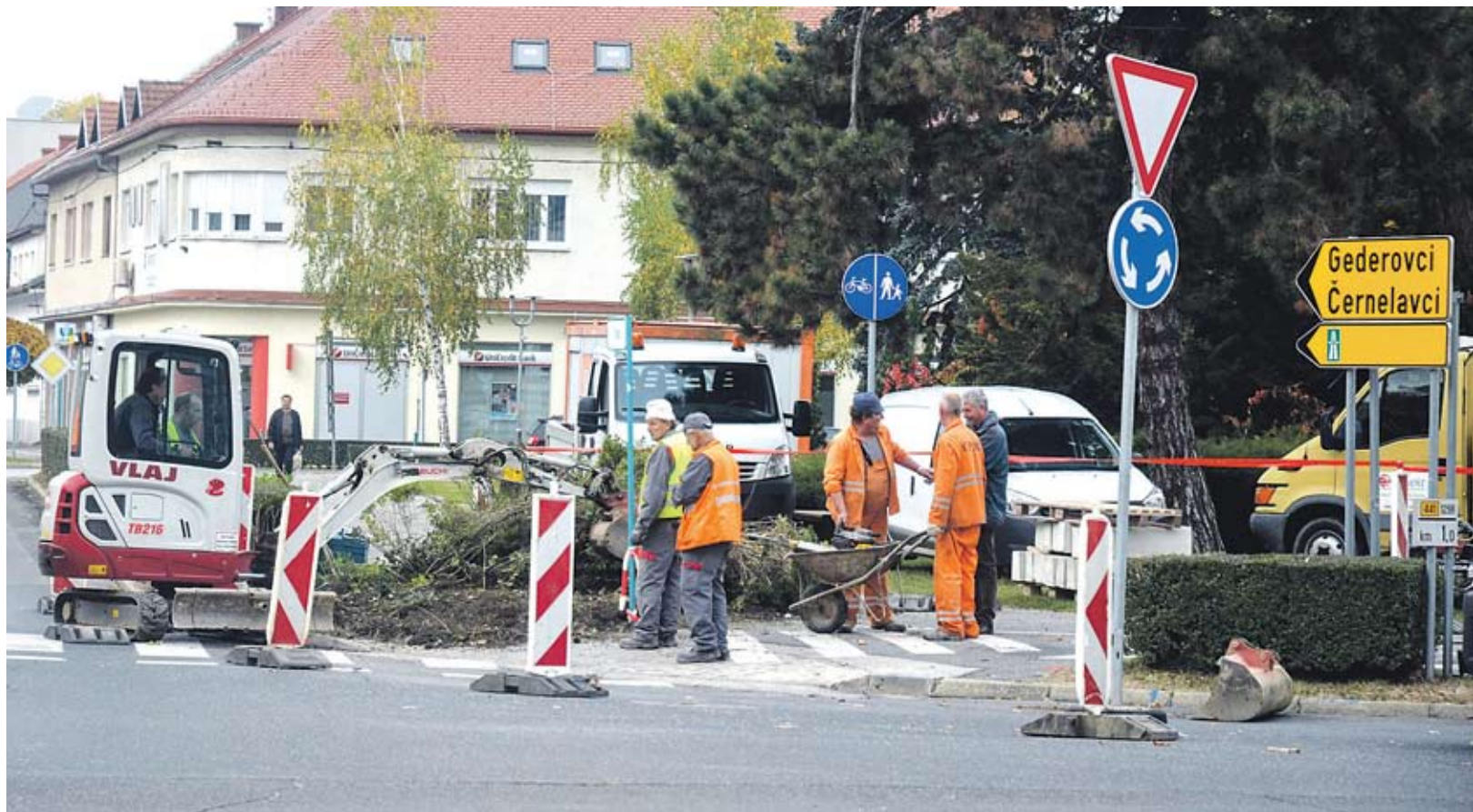
Delavci Pomgrada med gradnjo krožišča na Slovenski ulici.
