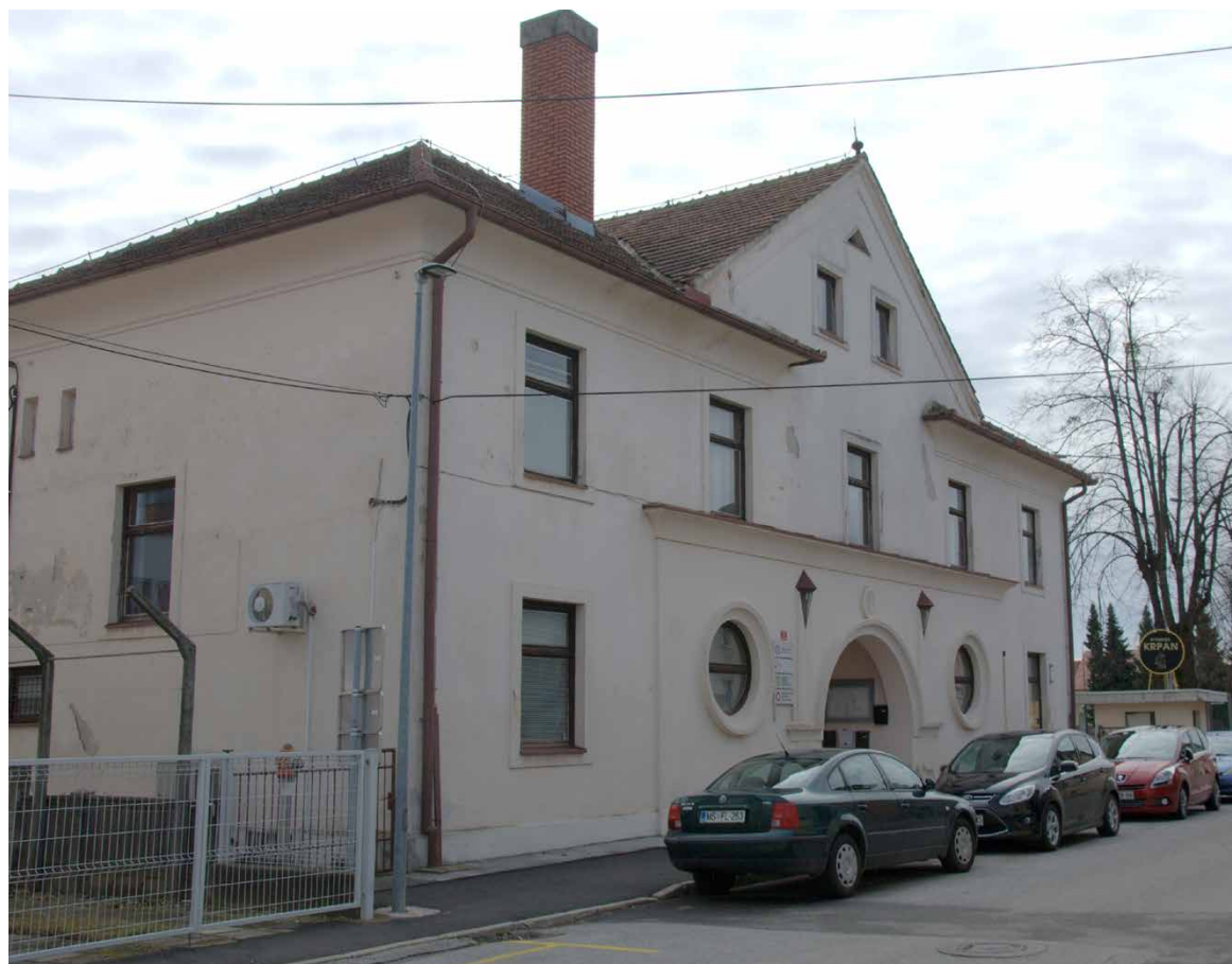
Legendarna stavba doma Partizan, ki je bil zgrajen leta 1929.
