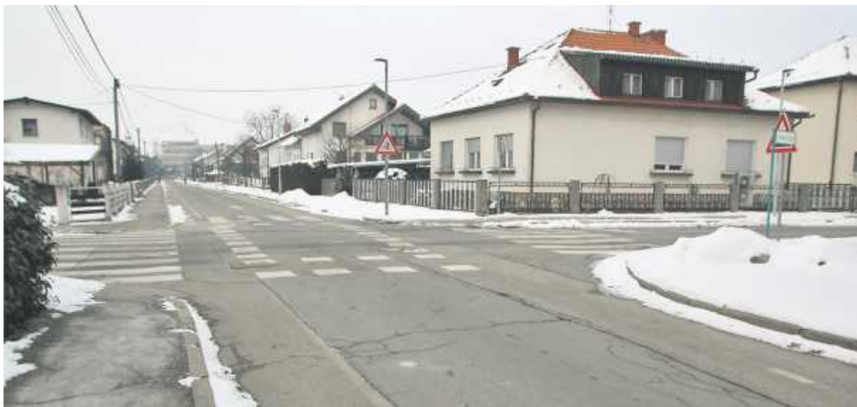
Dela naj bi se začela že v marcu in zaključila predvidoma junija.
