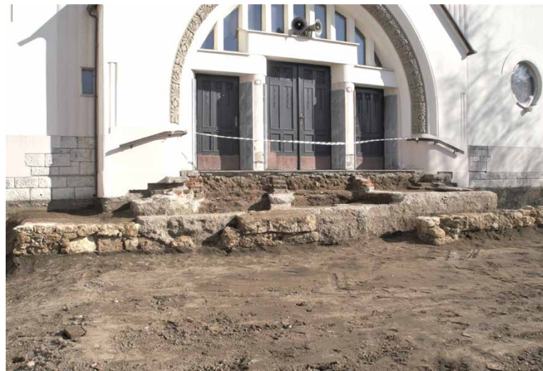
Obnova ploščadi pred stolno cerkvijo sv. Nikolaja se je začela že decembra in bo trajala do predvidoma junija. Postavili bodo kipa sv. Cirila in Metoda, slednji je zavetnik škofije, in manjše spominsko obeležje.
