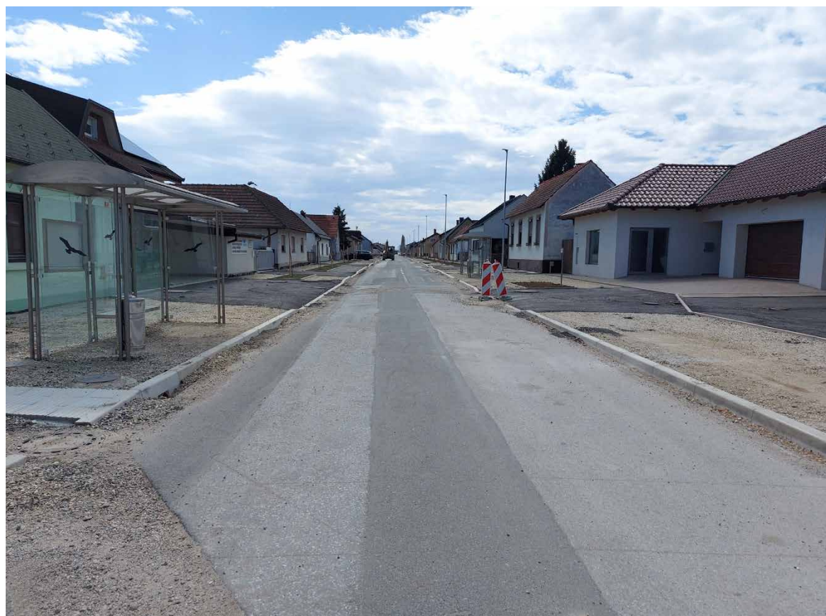
V okviru celovite ureditve Kroške ulice bodo obnovljene dotrajana javna razsvetljava ter zelene površine z obojestranskim drevoredom, postavljena bo nova urbana oprema.
