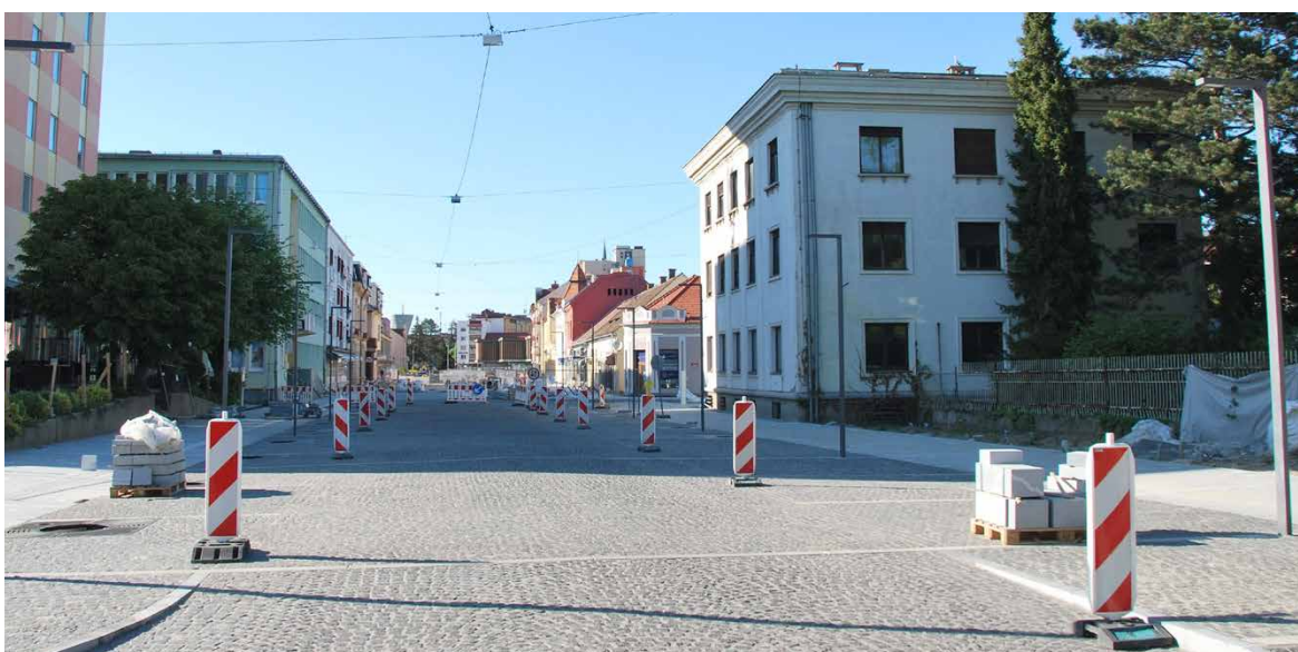
Na odseku Slovenske ulice med hotelom Diana in križiščem z Ulico arhitekta Novaka so dela večinoma končana.
