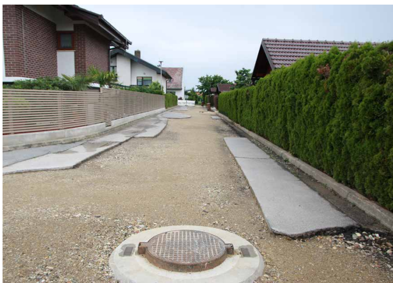
Na podlagi izdelane analize meteornege odvajanja v naselju se je pristopilo k izdelavi projektov za sanacijo kanalizacije.
