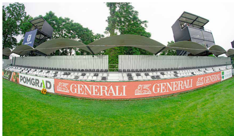
Na vzhodni tribuni so popravili dotrajane betonske plošče ter nanje namestili 550 črnih in belih sedežev, naknadno pa še streho.
