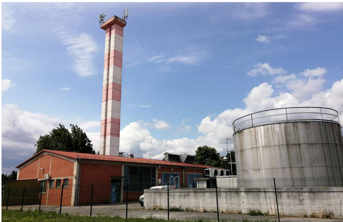
Kotlovnica na Lendavski ulici v Murski Soboti.
