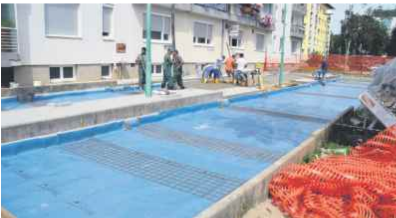
Tako so potekala obnovitvena dela.
