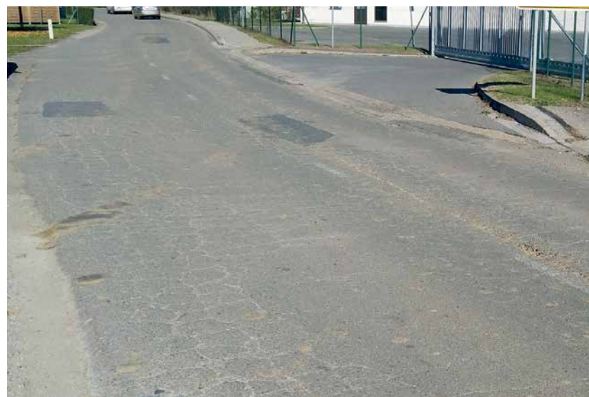
Cestišče v naselju Markišavci
