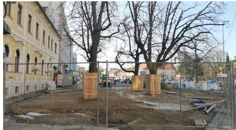
Dela pred hotelom Zvezda bodo predvidoma zaključena do konca marca.
