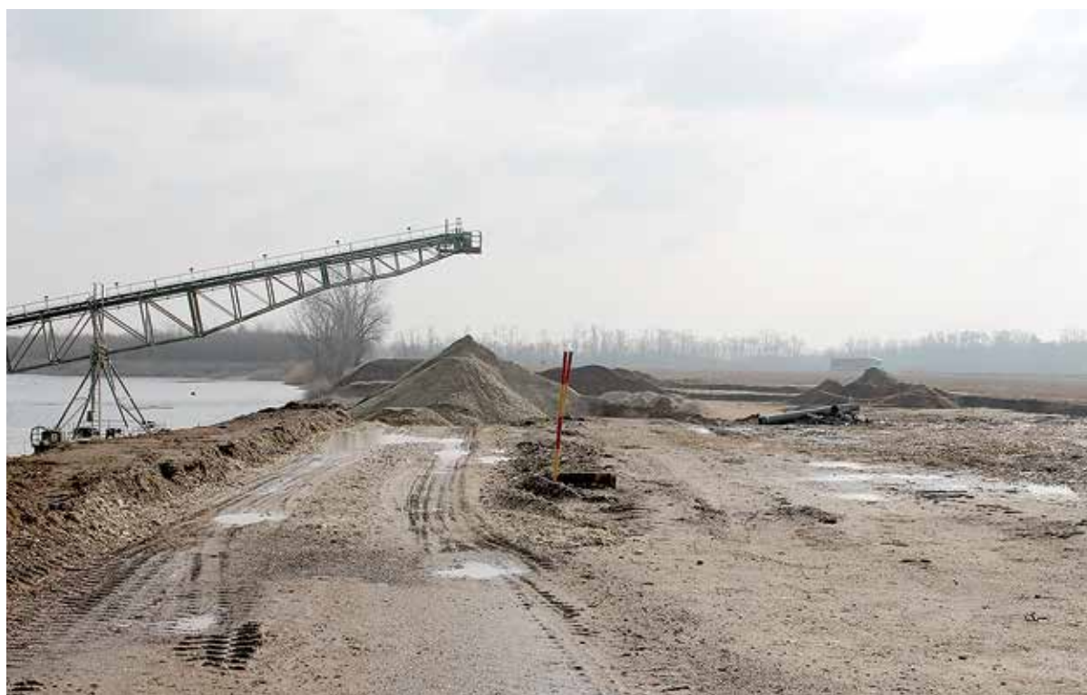
Ob Bakovski ulici v Murski Soboti odstranjujejo zgornje plasti zemlje in del občinske ceste, črpajo gramoz ter dokončujejo sanacijo brežin jezera.
