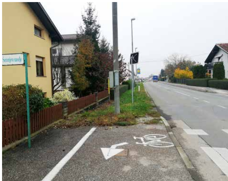
V Černelavcih si želijo tudi izgradnjo manjkajočega pločnika s kolesarsko stezo ob Gederovski ulici.
