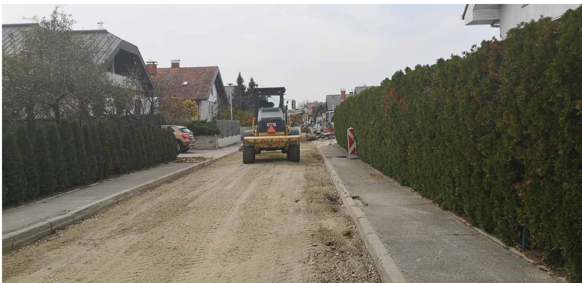
V načrtu razvojnih programov za obdobje med letoma 2020 in 2022 je predvidena tudi sanacija preostalih kanalizacijskih vodov v Černelavcih. / Foto: arhiv Mestne občine Murska Sobota
