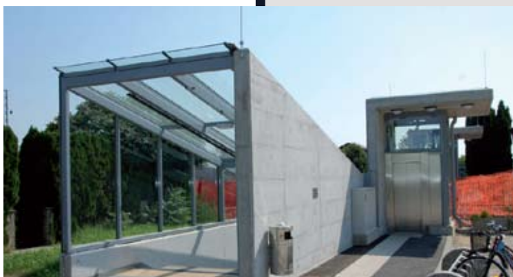
Podhod za pešce in kolesarje za pokopališčem v Murski Soboti
