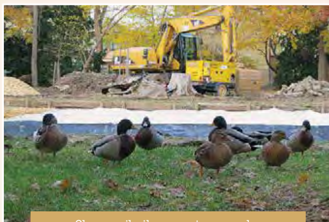
Obnova ribnika v mestnem parku
