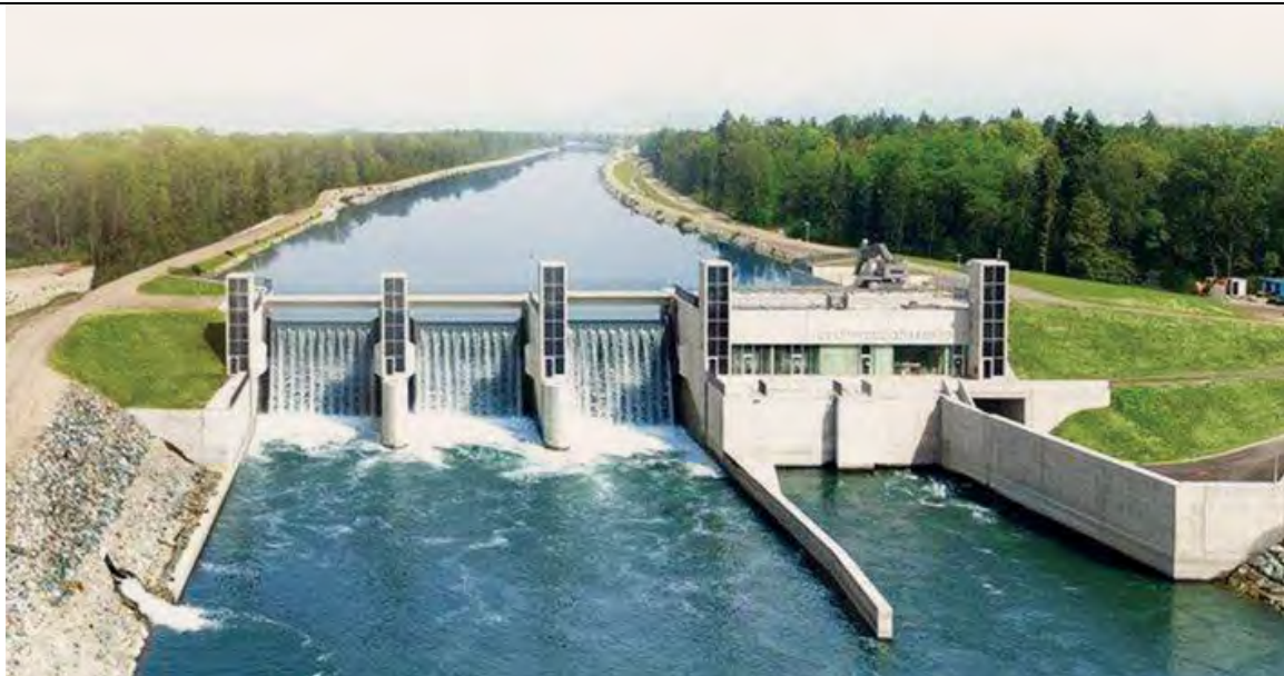
V Avstriji so pred dnevi zagnali novo hidroelektrarno, ki leži južno od Gradca
