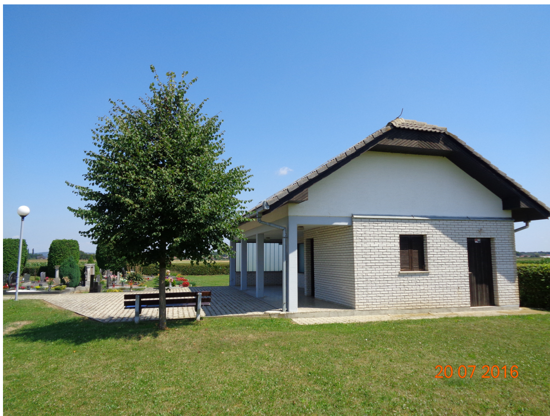
foto #1: Jugo - zahodna fasada
