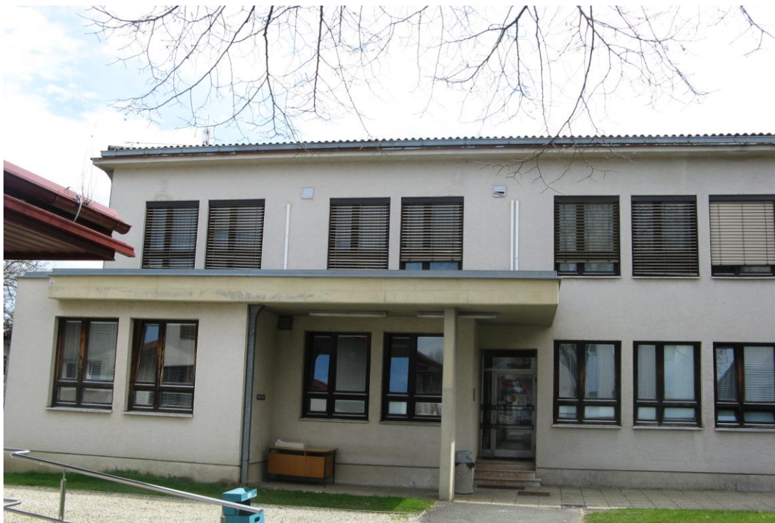
Zahodna, dvoriščna stran objekta 5.
