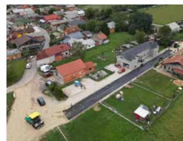
Po izgradnji vodovoda je mestna občina s sofinancerskimi sredstvi za romsko infrastrukturo in sredstvi iz občinskega proračuna obnovila glavne ceste skozi naselje in uredila meteorno odvodno v južni razbremenilni jarek.
