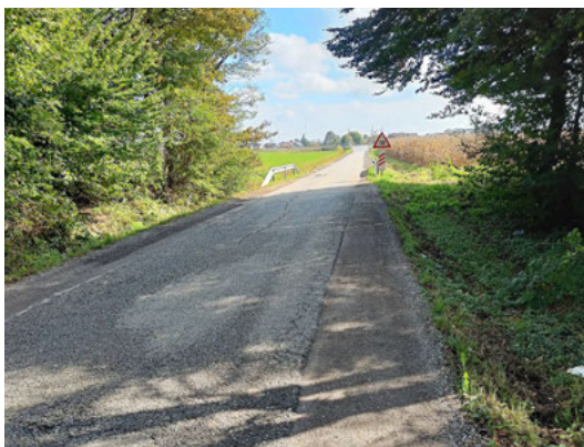
Izgradnja ceste Polana-Markišavci-Nemčavci
