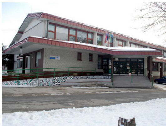
Prenova strehe in kotlovnice OŠ Bakovci
