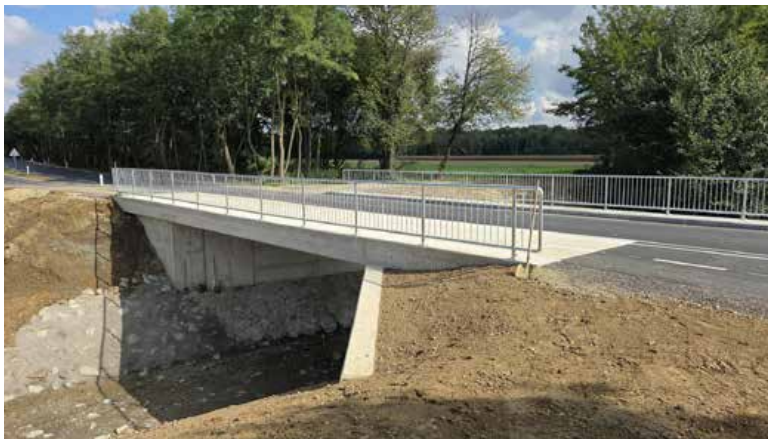
Gradbena dela ob rekonstrukciji cestišča so zajemala tudi novogradnjo mostu in enostranske dvosmerne kolesarske steze s pripadajočo komunalno infrastrukturo. | Foto: arhiv MOMS
