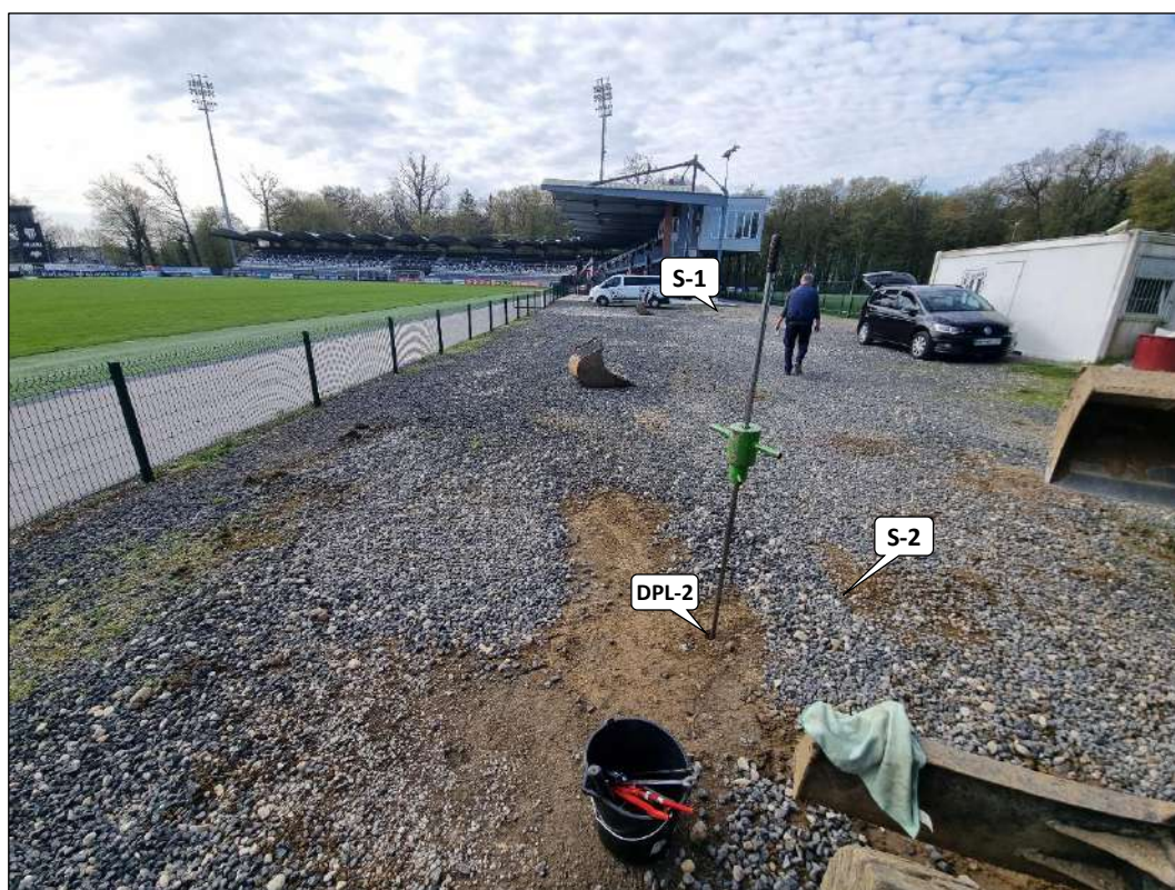
Slika 2: Območje gradnje in lokacije raziskovalnih del – pogled od severa (Foto: 04.04.2025)
