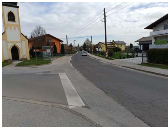
Slika 11 ; Potreba po izgradnji varnih in med sabo povezljivih površin za pešce v naselju Markišavci (na sliki območje ozkega grla med dvema križiščema pri Kapeli).
