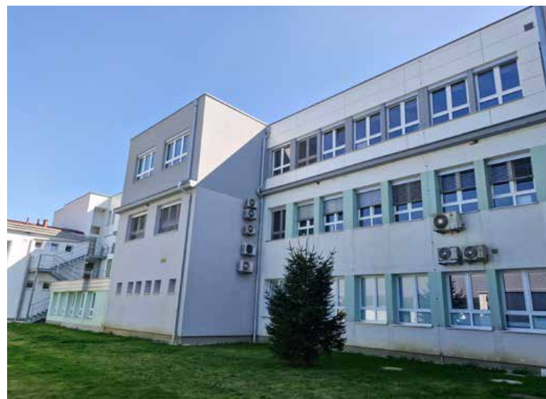
V preteklih letih so v celoti dogradili oziroma obnovili zgradbe v Murski Soboti.
