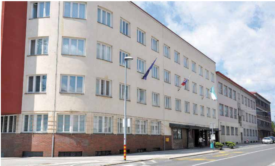
Prenova delavskega doma
