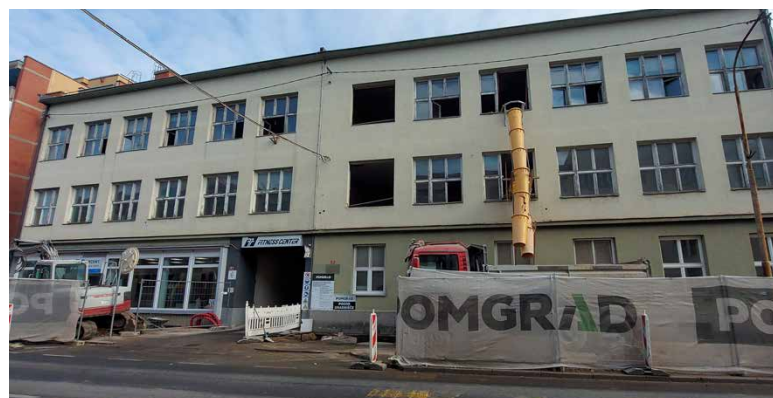
Zaradi gradbenih del avtobusno postajališče Slovenska ulica (pri občini) v smeri proti Lendavski ulici ni v uporabi. Pozivajo k posebni previdnosti na območju gradbišča, ki je za pešce zaprto.
