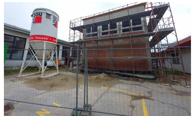
Na OŠ IV Murska Sobota poteka izgradnja novih prostorov v prizidku šole.
