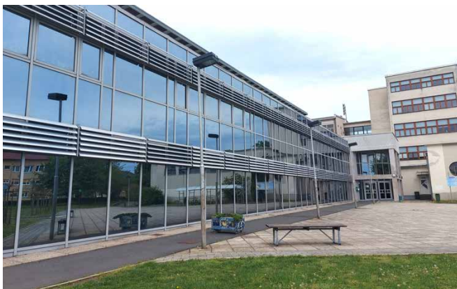
Na OŠ I Murska Sobota bodo zamenjali poškodovani parket.
