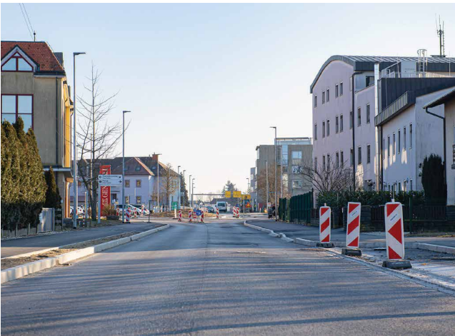
Dokončanje Gregorčičeve ulice
