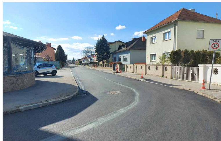
Obnova in preplastitve cest v Prešernovi ulici.
