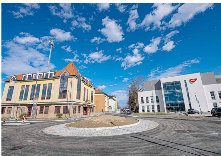
Asfaltiranje Gregorčičeve ulice je bilo izvedeno pred dnevi. Sledi zasaditev zelenih pasov in zaris talnih označb, ki bo izveden s polovično zaporo. Foto: Aleš Cipot
