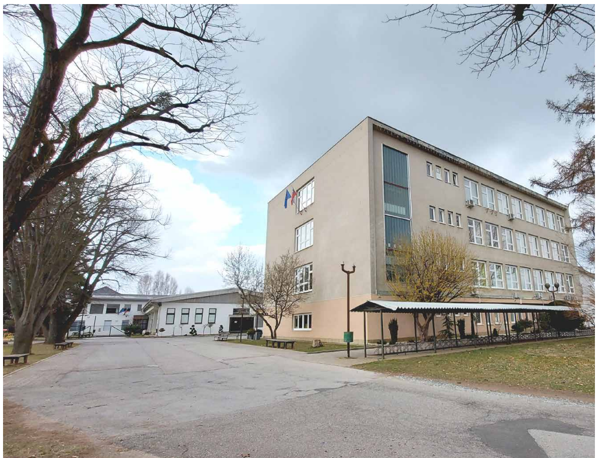
Energetske sanacije bosta deležni OŠ III in OŠ IV Murska Sobota.
