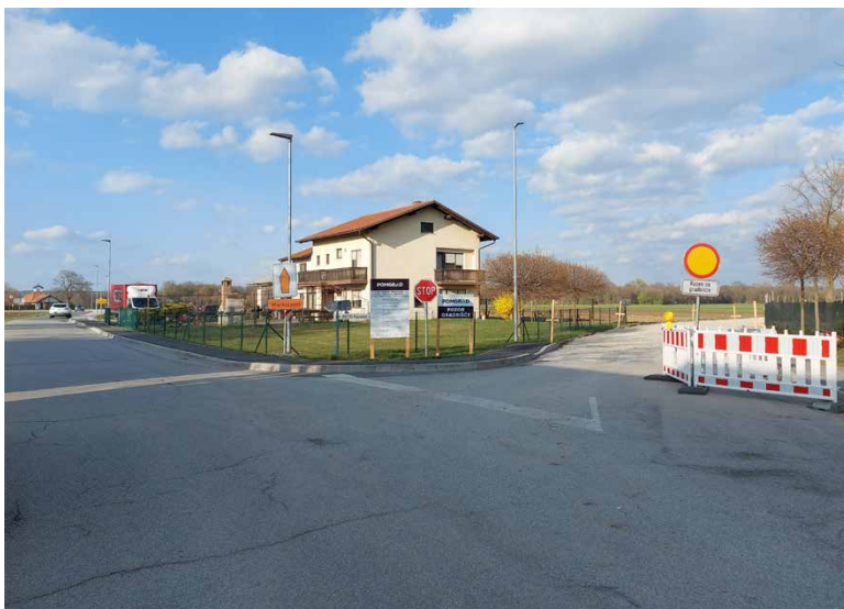
Rekonstrukcija ceste med Markišavci in Polano v skupni dolžini 1100 metrov.
