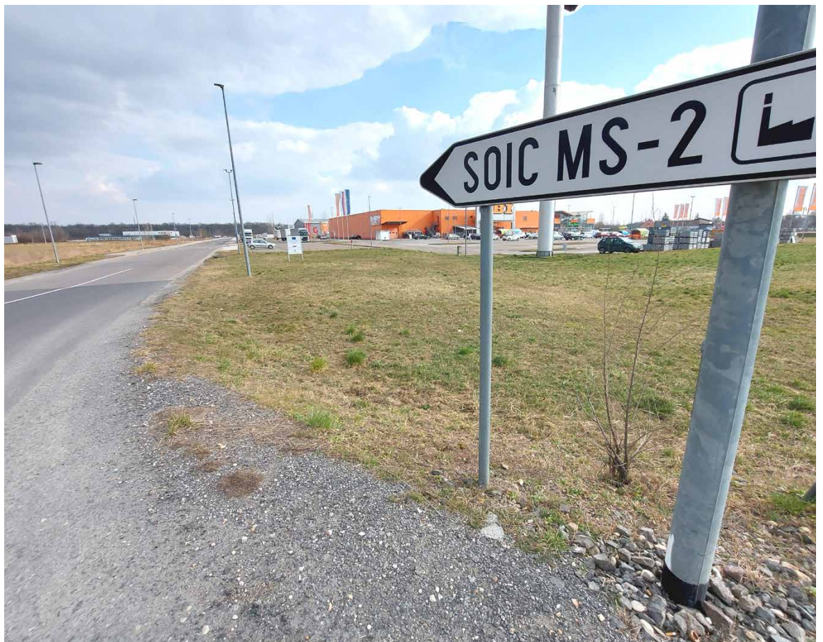
Ureditev območja druge in delno tretje faze predstavlja zaključno fazo ureditve cestne in komunalne infrastrukture severnega dela Severne obrtnoindustrijske cone v Murski Soboti.
