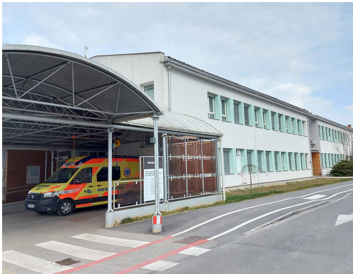
V sklopu nadzidave Zdravstvenega doma Murska Sobota bo izvedeno tudi nadvišanje jaška za dvigalo za dostop gibalno oviranim osebam.
