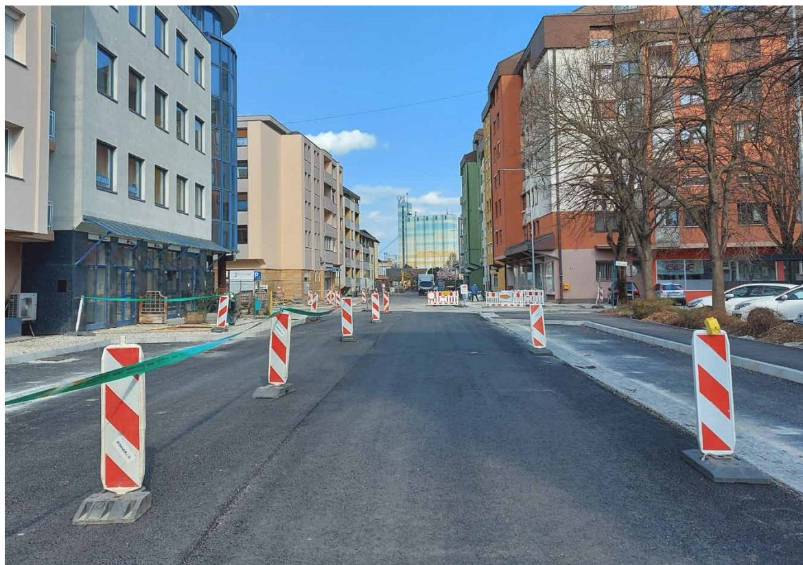
Ulica Staneta Rozmana bo dobila novo podobo. Celoten projekt, ki obsega obnovo te ulice ter v nadaljevanju še Gregorčičeve ulice in Slomškove ulice, je vreden skoraj tri milijone evrov.
