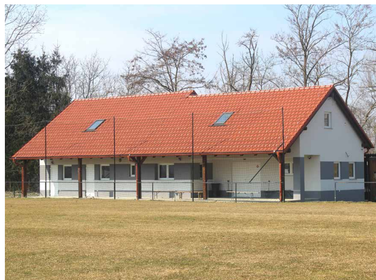
Za zaključek gradnje večnamenskega objekta ob nogometnem igrišču je namenjenih 24.630 EUR.
