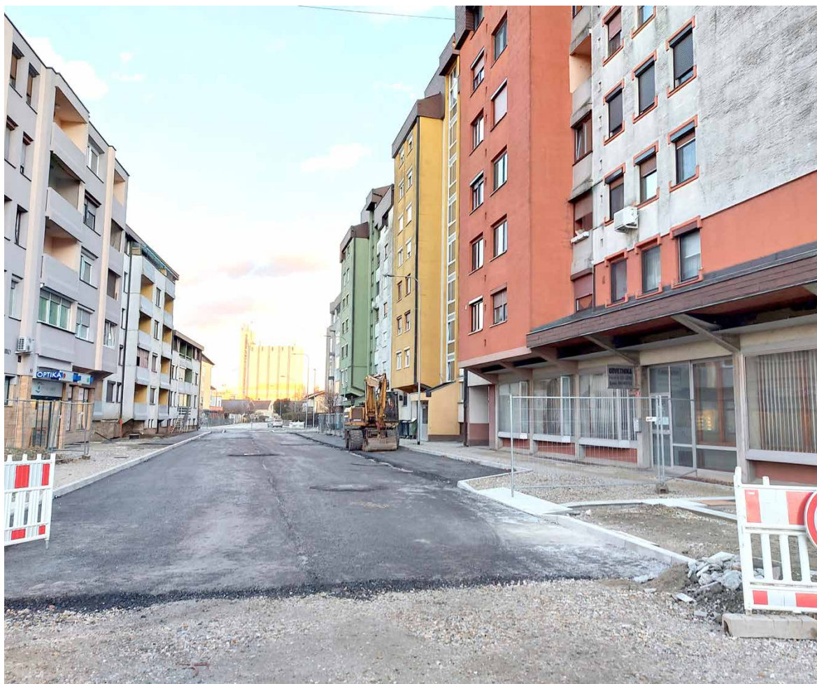
Trenutno potekajo dela na Ulici Staneta Rozmana, ki bo prenovljena v dolžini 270 metrov.
