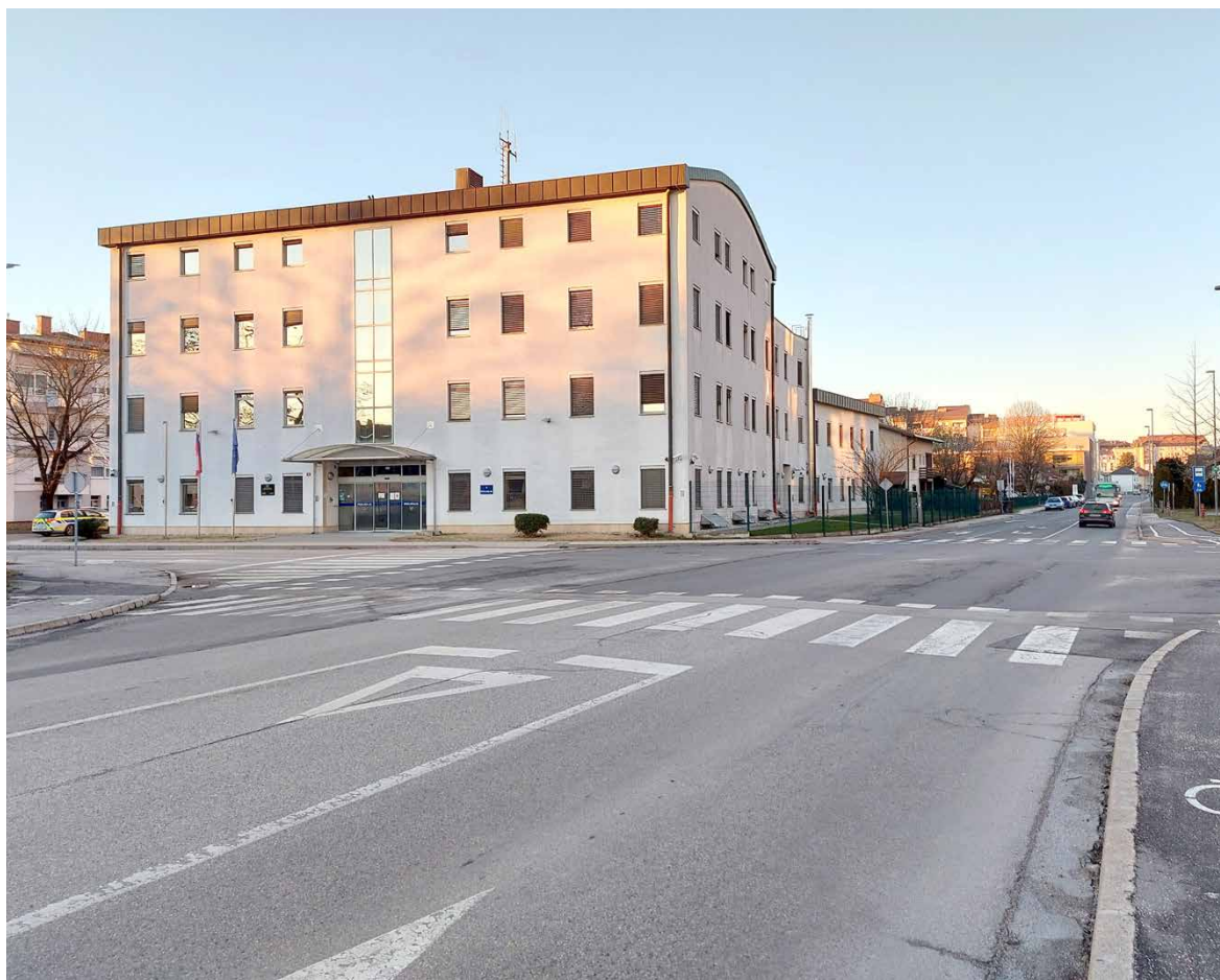
Nadaljevala se bo celovita obnova Gregorčičeve ulice z vmesnim krožiščem z Ulico arhitekta Novaka.
