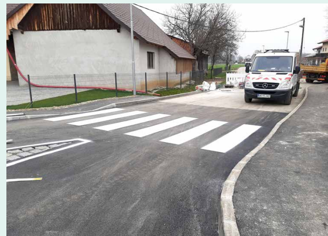
Ustrezno vzdrževane cestnoprometne površine in naprave prispevajo k varnosti v cestnem prometu.
